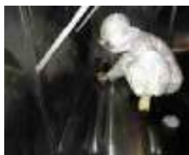
排水設備内の清掃
